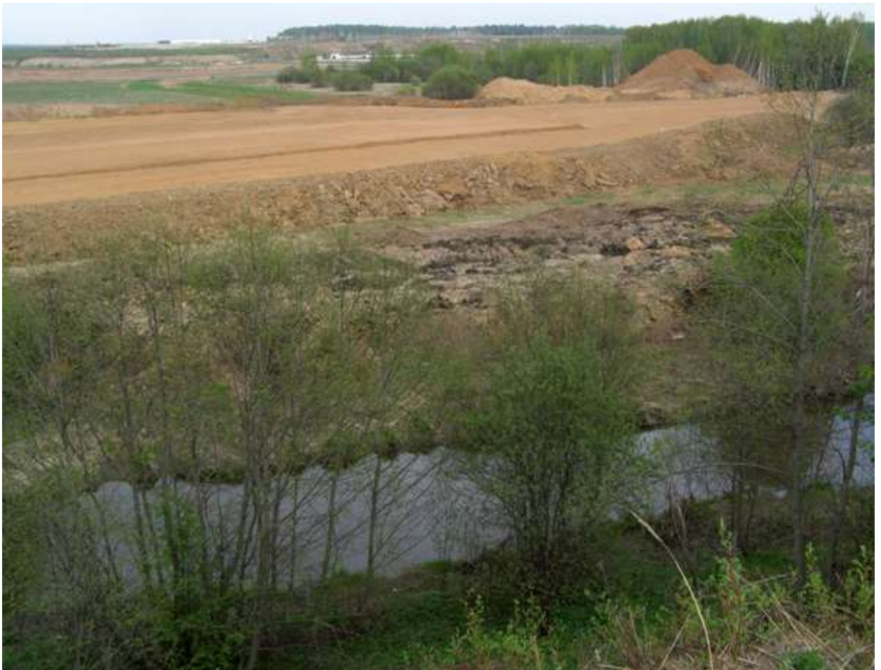
Фото 1. Отсыпка грунтовой площадки в пойме р.Клязьмы, входящей во второй пояс ЗСО источников питьевого водоснабжения. На заднем плане – участок вырубki защитных лесов под строительство ВПП-3. Фото М.В.Семенцовой
